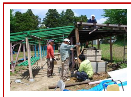
ピザ焼の石窯がある釜場の屋根を張り替え、一部、柱も交換しました。
